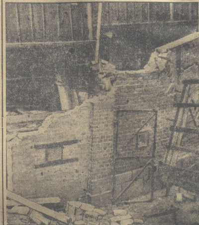
Die Grundmauern der den Kalimerten benachbarten Zuerfabrik stehen im Grund. Die oberen Gebäudeteile hängen in der Luft.
