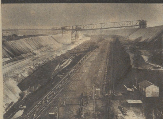
Eine neuzeitliche Förderbrücke. Rechts der große Abraumbagger, der die Erdmassen zur Brücke bringt, auf der sie auf Laufrollen hind, quer über die Grube geschafft und auf der anderen Seite abgeworfen werden. Im Vordergrund Züge der Förderwagen.
