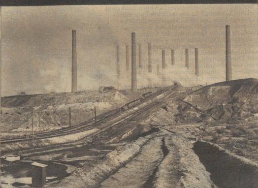
Transport der Braunkohle mit Großraumwagen — 100 Tonnen Kohle in jedem Zug — zur Briquetfabrik
