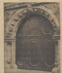
Unten: Altes steinernes Portal am Hause Gräser einem Wohnhause, das ehemals einem Textilindustriellen gehörte; die Holz- tür ist erneuert
