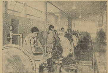
Die Waschmaschinen im Waschhaus
