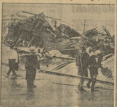
Schwer beschädigte Häuser in Nagasaki.
