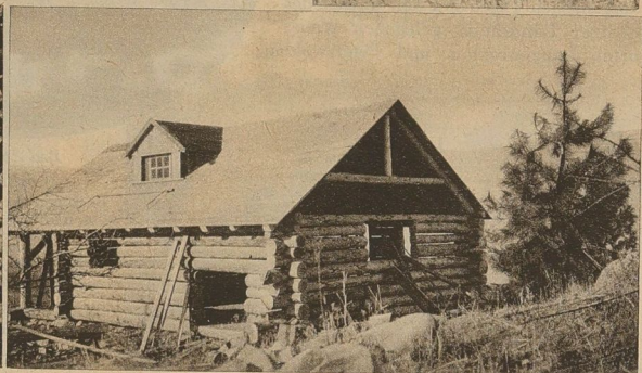
Unten: Bau eines Blockhauses
