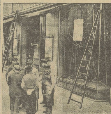
Eingeschlagene Fensterheben bei Wertheim.
