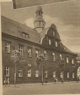
Links: Rathaus (renoviert) in Ronneburg
