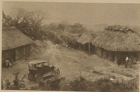
Rechts: Im mexikanischen Petroleumgebiet
