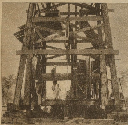
Arbeiten im Bohrturm: Drehen des Bohrers
