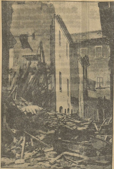
Eingestürztes Wohnhaus in Sinigaglia.
