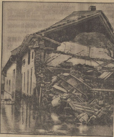
Eingestürztes Haus in Kasan an der Marz.
