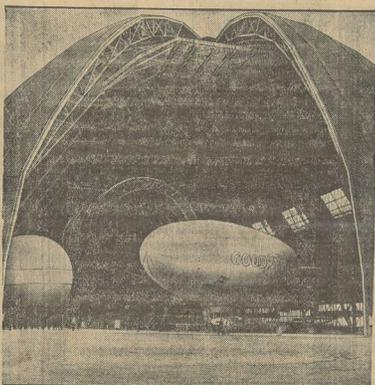
Bild in die neue Riesenhalle der Goodyearwerke in Akron (U.S.A.). Man sieht die drei bedeutsamen Entwicklungsstufen des Luftschiffs; links den Freiballon, rechts das unklare Kleinluftschiff und in der Mitte den im Bau befindlichen Marine-Riesengepöppel „Akron“, der nach Vollendung das größte Luftschiff der Welt sein wird.
