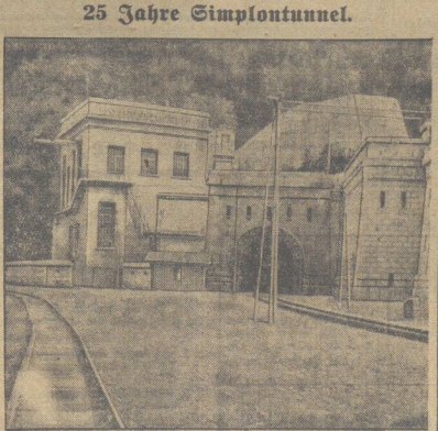
Der Nordendeingang des Tunnels.
