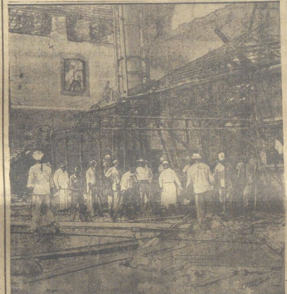
Maschinen und Werkze bei den Bergungsarbeiten auf der Trümmerstätte.
