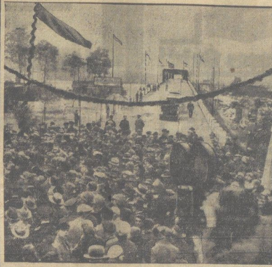
Die feierliche Eröffnung der Brücke.
