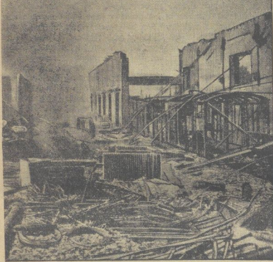
Der ausgebrannte Bahnhof Gens-Annaberg.
