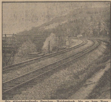
Die Eisenbahnstrecke Dresden-Reichenbach, die an dem Berg vorbeiführt.
