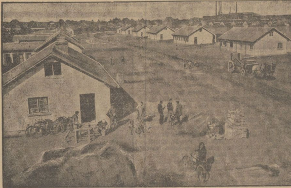
Bild in die neue Arbeitslosensiedlung in Brandenburg a. d. Spree.
