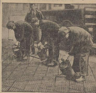
Eisenplatten werden mit Teer zusammengeklebt.
