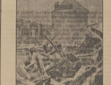
Die verfallenen Trümmer der Ruine des alten Schloßes zu Stuttgart, wo sich nach Erdbeben des Brandes weitere Einstürze von Gebäudeteilen ereigneten.
