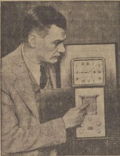
Das Neueste auf dem Gebiete der Rundfunktechnik stellt ein automatischer Radio-Einsteller dar, der von dem Ingenieur Giacomo in Rompat erdacht wurde. Der Apparat schaltet selbsttätig zur gewählten Zeit bis zu 6 verschiedene Radiostationen nacheinander ein, so daß man sich jetzt mit seiner Hilfe aufwecken lassen kann.
