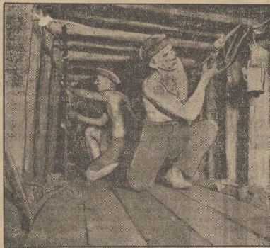
Mitglieder der Rettungstolonnen in dem nach der Unglücksstelle vorgebrachten Stollen.
