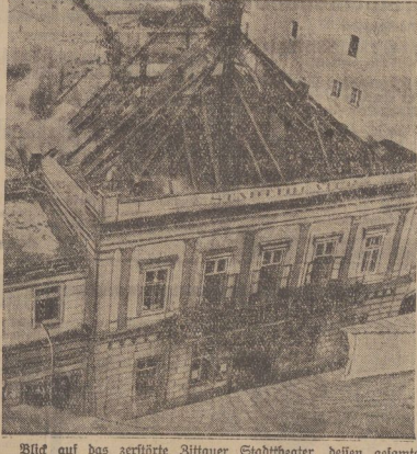
Blick auf das zerstörte jidische Stadttheater, dessen gesamte Inneneinrichtung einem nächtlichen Brand zum Opfer fiel.
