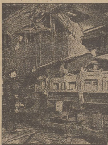
Die inelander gehobenen Wagons im unterirdischen Schacht.
