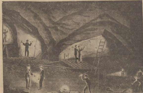
Alte Darstellung von Bohrarbeiten in dem Rammelsberger Erzbergwerk, das mehr als 100 Jahre alt ist und jetzt geschlossen werden soll. Die Schließung würde sich für die Wirtschaftslage der Gemeinden des Unterharzes katastrophal auswirken.
