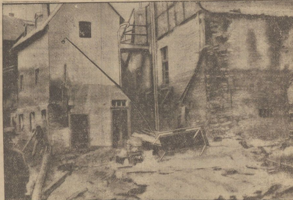
In allen Orten des unteren Moseltals richtete die Unwetter-Katastrophe furchtbare Verwüstungen an. Die Heldröde in den Weinbergen sind weggeschwemmt , die Böcker liegen unter Wasser und viele Wohnhäuser sind schwer beschädigt worden. Nur in eine Strasse von Wals a. d. Mosel nach de. Katastrophe .
