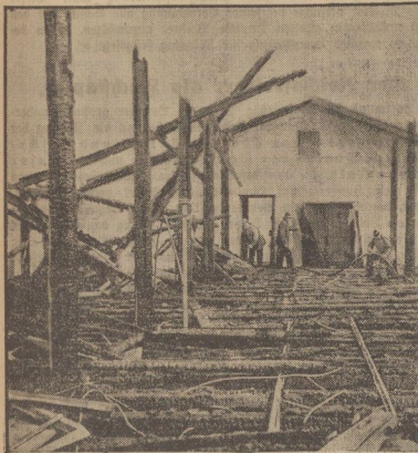
Bild in eines der ausgebrannten Fabrikgebäude.
