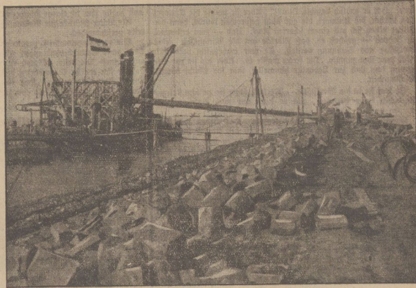
Der Damm, der die Quibersee vom Meere abtrennen soll, ist jetzt nach jahrelangen Arbeiten fertiggestellt worden. Damit hat sich die Quibersee in ein Binnenengewässer verwandelt, das auf große Strecken hin trodengelegt und der Landwirtschaft erschlossen werden soll.
