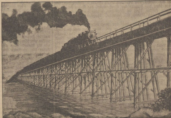
Ein Zug mit Kiehladung passiert die Holzbrücke über dem Tal, in dem der Hooverdamm errichtet wird.
