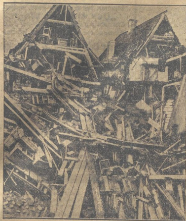
Die Ruinen der eingestürzten Straßunder Wohnhäuser. Zwei zweistöckige Wohnhäuser sind in Straßund mit ungeheurer Gewalt eingestürzt. Das Dachgebälke alte Mauerwerk konnte dem mächtigen Gewicht eines neuen Einbaus nicht standhalten. Da die Anlässe des Hauses kurz vor dem Einsturz gemauert werden konnten, wurden nur 5 Personen verwickelt. Die Bergung der zum Teil erheblichen Beteiligungen ist verhältnismäßig kurzer Zeit gelungen.
