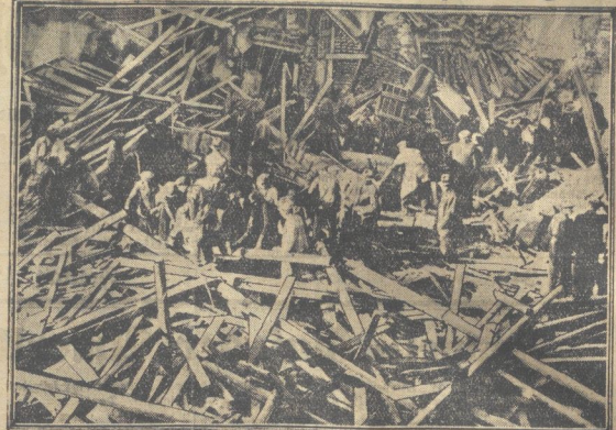
An Stelle eines stolzen Hochhauses — ein schauerliches Beton-Massengrab
