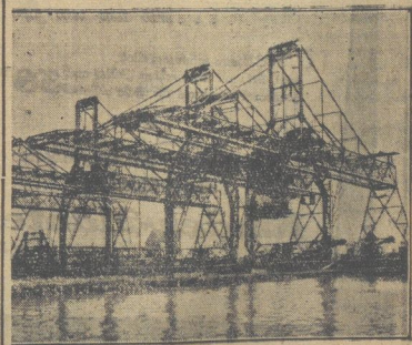
Verladebrücken der Krupp-Werke.
