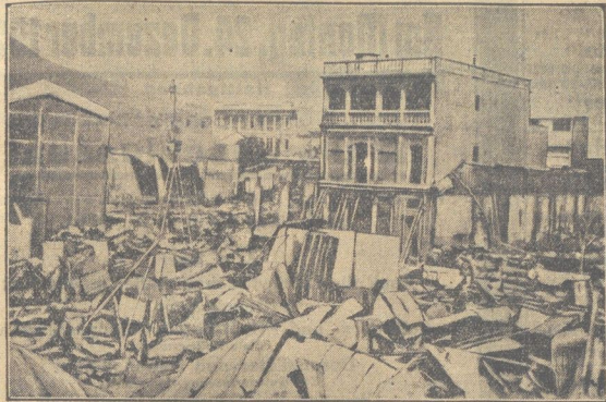
Der zerstörte Hauptplatz der ehemaligen Stadt Talca hat nach dem gemäßigten Erdbeben, das die Westküste von Südamerika heimgesucht hat, ein erschüttertes Bild. Kaum ein Gebäude ist in der dort wohlhabenden Stadt ohne Schäden geblieben. 35 000
