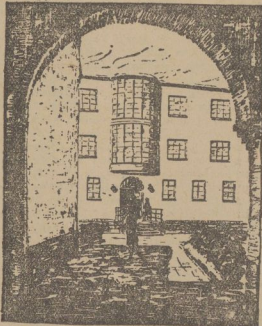
Blick auf die Eigenbetriebe (Hintergebäude).
