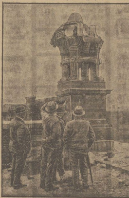
Festsetzungen auf dem Dach des Gebäudes.
