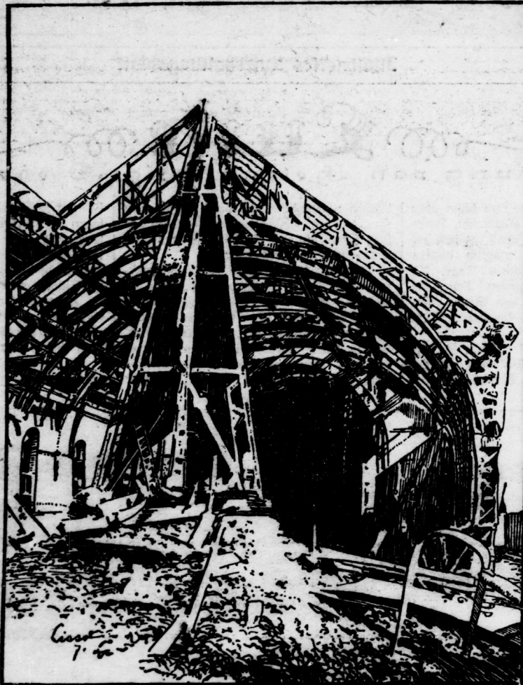
Die zusammengeschossene Kirche in Pilly-Montigny bei Cambrai.
