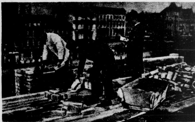
Physiotechnische, arbeitswirtschaftliche Untersuchung des Bauarbeiters Atlantic Feststellung der mittleren Arbeitszeit für das Vermauern von Steinen in verschiedener Schichthöhe
