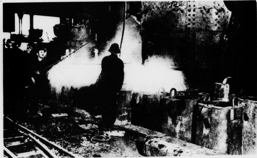
Stätten deutscher Arbeit: Berliner Illustrations-Gesellschaft Im Walzwerk einer oberösterreichischen Zinkhütte (oben) — Das Einbringen flüssigen Stahls in Tonformen (unten)
