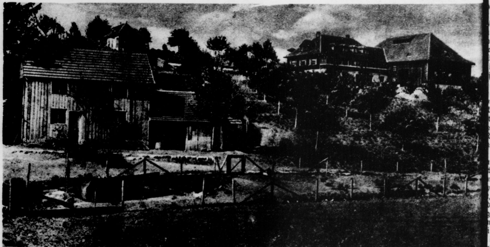
Das neugeschaffene Erholungsheim „Ruh am See“ der Stuttgarter Metallarbeiter
