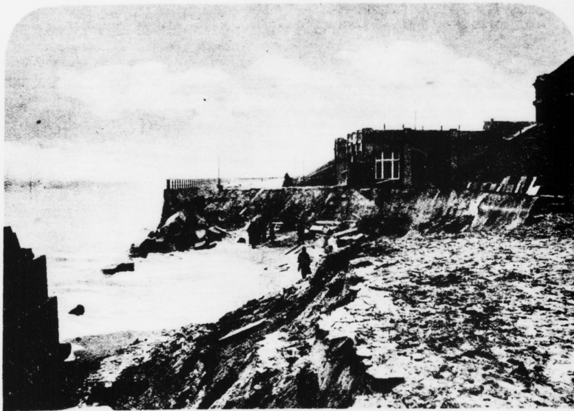
Sturm Schäden auf Westerland
