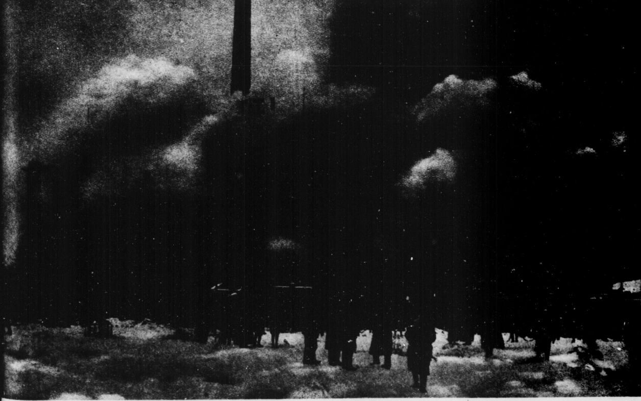
Brand einer der größten Schokoladenfabriken Deutschlands Die Sarotti-Schokoladenfabrik in Berlin-Tempelhof, die viele hundert Menschen beschäftigte, wurde unlängst durch ein furchtbares Schadenfeuer zerstört
