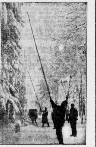
Störungsstrupp an der Arbeit. Die verriegelte und bereifte Telegraphenbrücke werden von Störungsstruppen der Telegraphenbauämter von ihrer schweren Last befreit.
