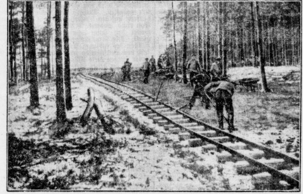
Weiterbau der Reichsbahnbahnen auch im Winter Trotz Schnee und Frost werden die Arbeiten an den Reichsbahnbahnen mit allen Kräften ununterbrochen weiterbetrieben. Unterwegs zeigt die Züge auf der Baustrecke Berlin-Stettin. In der Mitte der Erhebung sind Arbeiter, um die neue Baustrasse mitten durch den Wald. Die Arbeiter sind dabei, das Terrain vorzubereiten.
