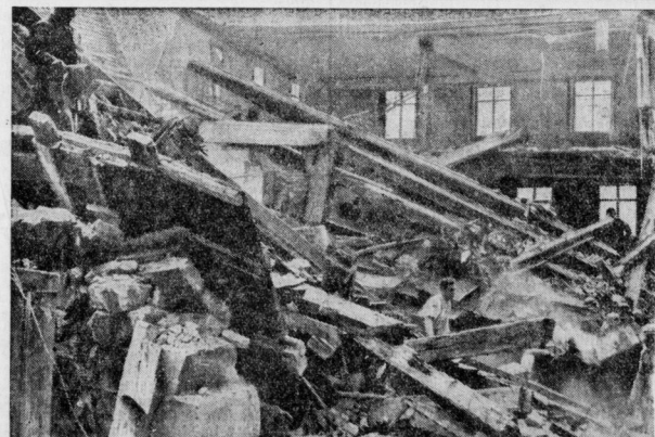
Das furchtbare Einsturzungsglück in der Schule von Winterbach. Blick auf die Trümmer der alten Schule in dem württembergischen Ort, die während des Unterrichts einstürzte. Der Hauptlehrer Kohnle und sieben Kinder wurden von dem herabstürzenden Mauerwerk erschlagen. Vier Kinder wurden schwer, zwölf leichter verletzt.
