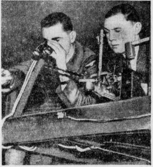
Ein englischer Ingenieur hat eine besondere Einrichtung erfunden, die es ermöglicht, ein Zielverwerfen mit kleinen Bombenmodellen schulmäßig durchzuführen. Unter Anwendung eines Zielverwerfers werden kleine Fliegerbombenmodelle auf ein unterhalb der Platte, auf der die Flieger-schüler liegen, vorbeiziehendes Panorama abgelesen. Der Fliegerlehrer beobachtet gleichzeitig mit einem starken Fernglas die Zielwerte des Schülers.
