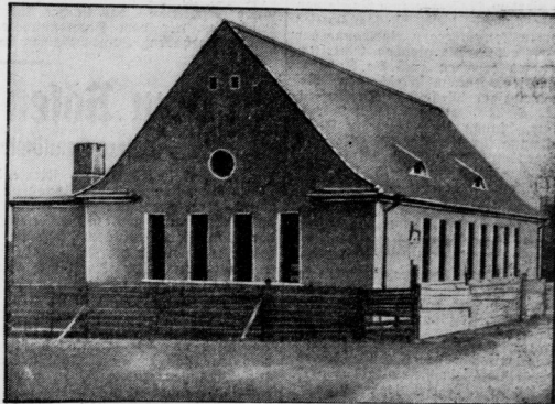
Die im Rohbau fertige Turnhalle des Reform-Real-Gymnasiums.
