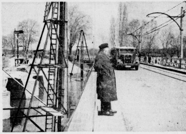
Die neue Holzbrücke zwischen Ammendorf und Schkopau. Phot.: Oest Links die Pfeiler der alten 14-Bogenbrücke, die abgerissen wird.
