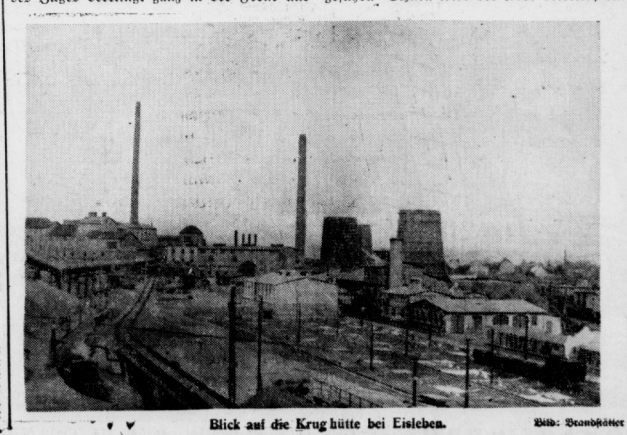
Blick auf die Krughütte bei Eisleben.
