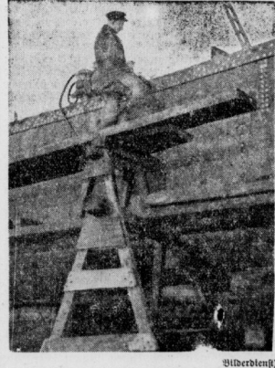
Schiffsbauer beim Nieten.
