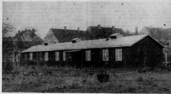
Die neue Unterkunftsbaracke des Sanitätszuges Merseburg auf dem Städtischen Bauhof.
