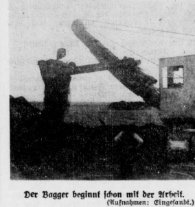
Der Bagger beginnt schon mit der Arbeit. (Aufnahmen: Eingeliefert.)
