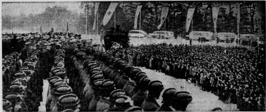
2000 Kilometer des Reichsautobahnnetzes sind nunmehr fertiggestellt. Mit einem feierlichen Akt übergab der Generalinspektor für das deutsche Straßenwesen, Dr. Todt bei Erker den 2000. Reichsautobahnkilometer dem Verkehr. Zur gleichen Stunde wurden insgesamt sechs neue Autobahnstrecken freigegeben. Neben zahlreichen hervorragenden Ehrengästen nahmen auch 2000 Reichsautobahnarbeiter aus dem ganzen Reich an der Feier teil. Man sieht hier den Generalinspektor für das deutsche Straßenwesen bei seiner Ansprache während der Feier bei Erker. (Scherl-Bilderdienst-M.)
